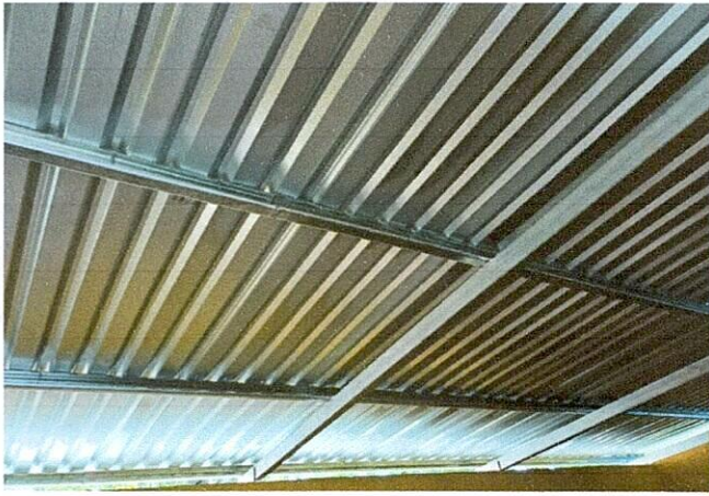
Foto1: Cambio de estructura de madera a metal y cubierta de lámina troquelada calibre 26 del módulo.
